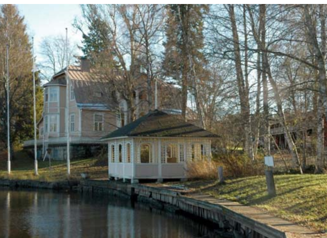
Entisen kauppias Pulkisen huvilan ranta on rakennettu kiviarkkoista 1900-luvun alussa. Kuva: Kirsti Kovanen.
