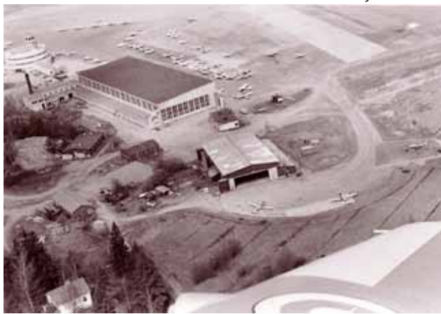
60-luvulla otetussa kuvassa näkyy mm. Ilmavoimien yhteyslentueen parakki. Automiesten valkoinen talo erottuu vasemmassa alanurkassa.
